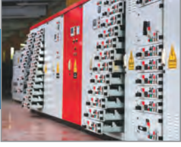
AG PANOLAR (TEDAŞ panolarından form 4b-çekmeceli, 6400A-100kA'e kadar)
