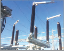
YG KEŞİCİ - AYIRICILAR (420kV'a kadar)
